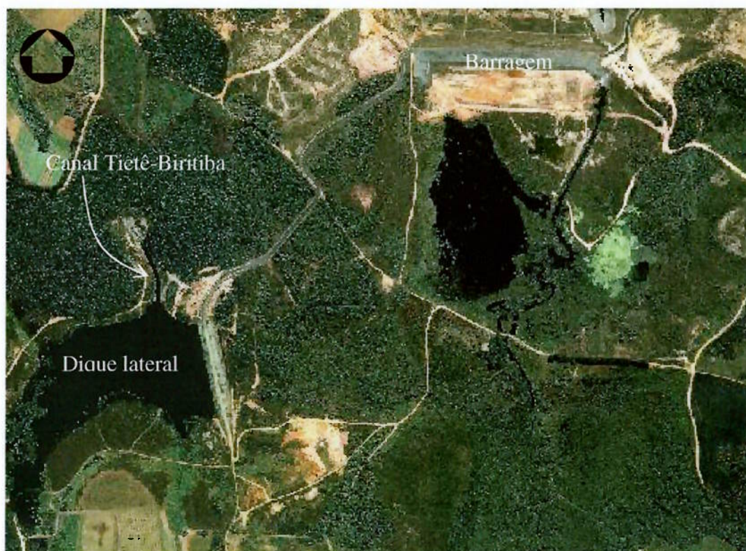
Foto 2.3.3: Barragem de Biritiba (em construção) e dique lateral
