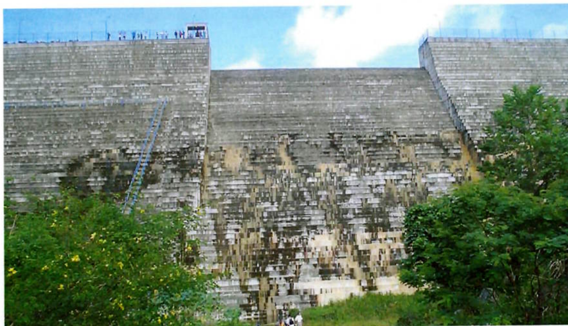
Foto 9.8.1.6.1: Dissipador em degraus
