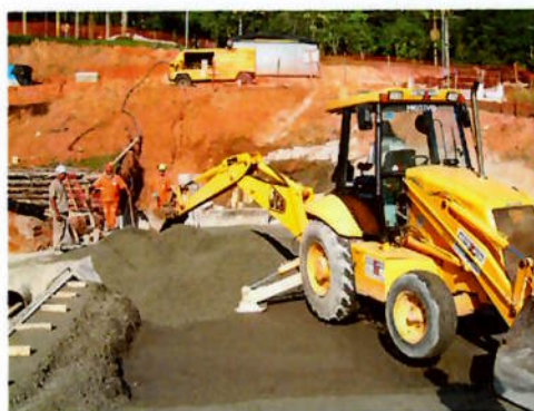
Foto 6.8.2.2: Lançamento e espalhamento
