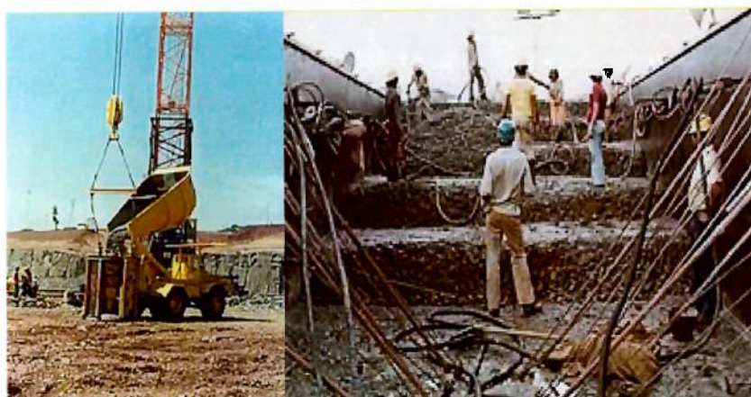
Foto 5.2.2.1: À esquerda, transferência de concreto do caminhão para o equipamento de lançamento. À direita, arranjo clássico de lançamento de uma camada de concreto convencional dividida em subcamadas.
