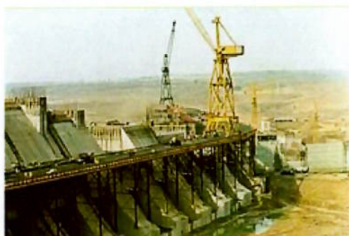
Foto 5.2.1: Barragem de concreto em construção
