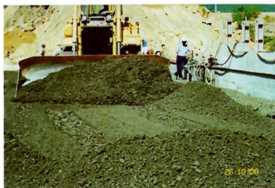
Foto 6.8.2.3: Lançamento e espalhamento
