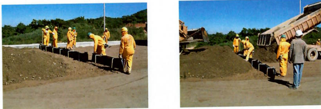
Foto 6.5.5.1: Juntas de Contração
