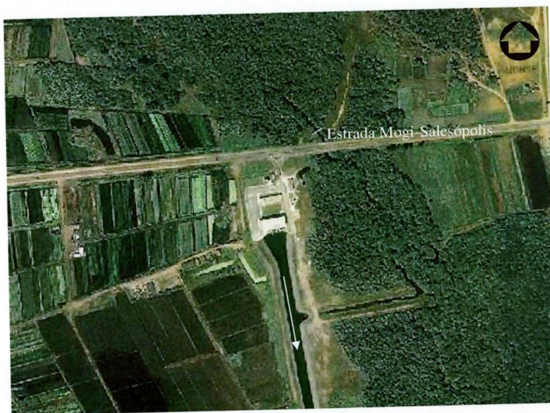
Foto 2.3.2: Estação Elevatória e canal Tietê-Biritiba
