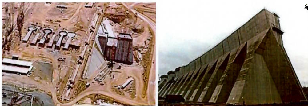
Foto 5.2.6.1: Vistas geral e lateral (por jusante), em primeiro plano, de um bloco de contraforte concluído em Itaipu.
