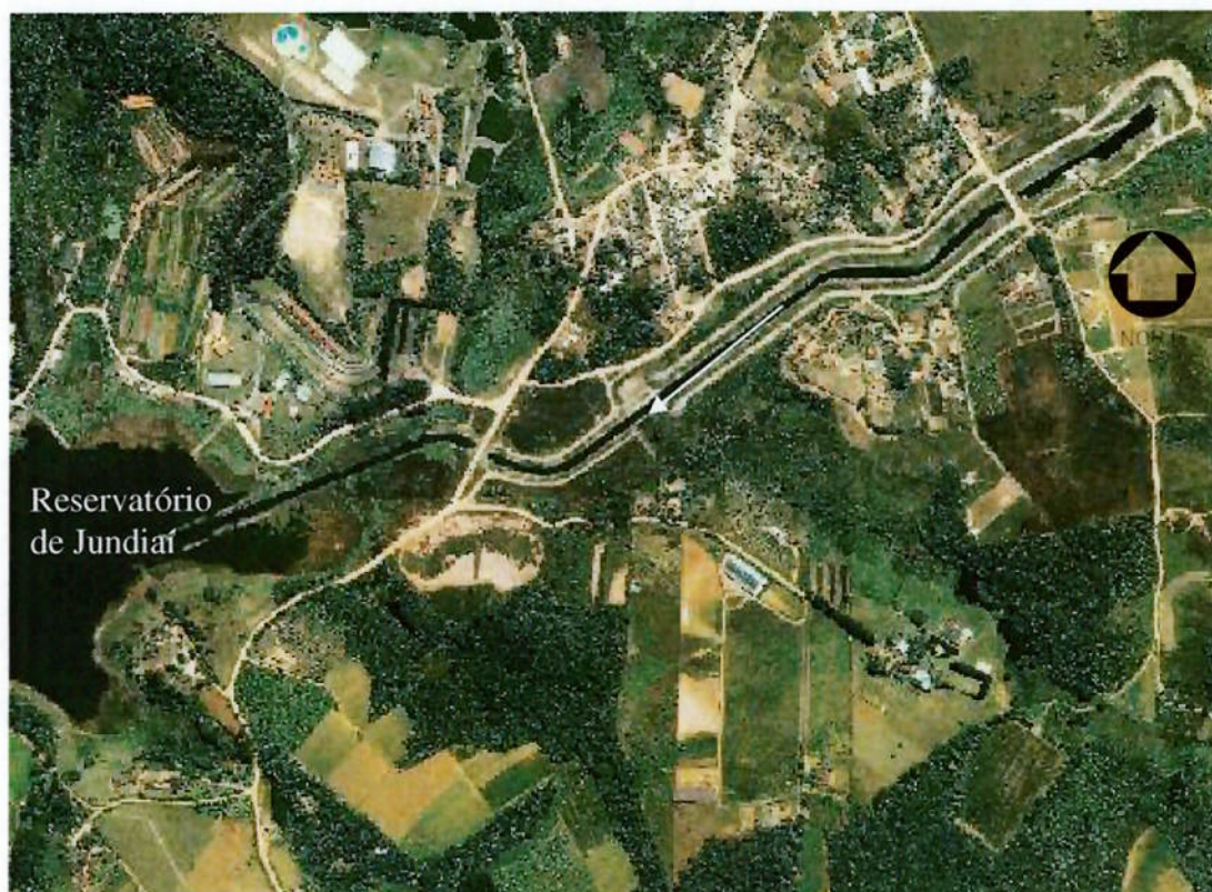
Foto 2.3.5: Canal-Túnel-Canal para o reservatório de Jundiá (chegada)
