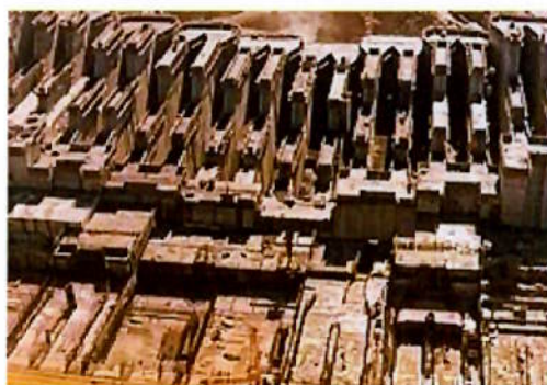
Foto 5.2.7.1: Construção da barragem principal de Itaipu, concebida em blocos de gravidade aliviada. Na parte inferior, as casas de força (vista aérea de jusante para montante).
