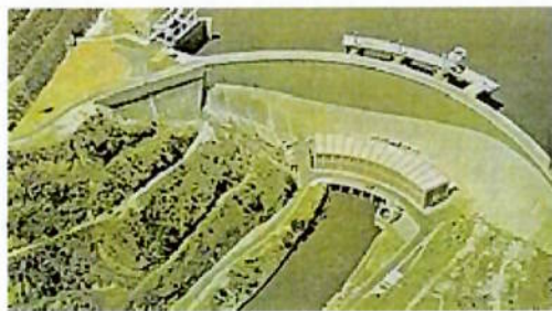
Foto 5.2.8.1: Barragem em arco da usina de Funil, no rio Paraíba do Sul
