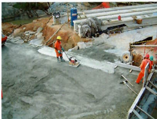
Foto 6.5.7.1: Juntas de construção horizontais
