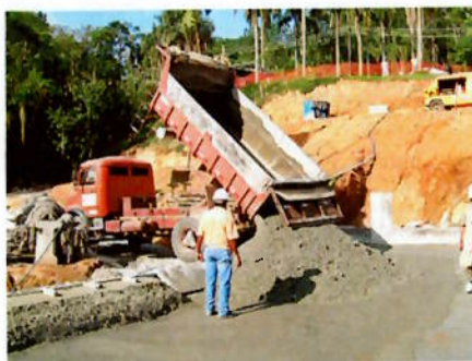
Foto 6.8.2.1: Lançamento e espalhamento
