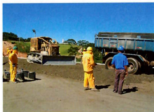
Foto 6.8.2.3: Lançamento e espalhamento
